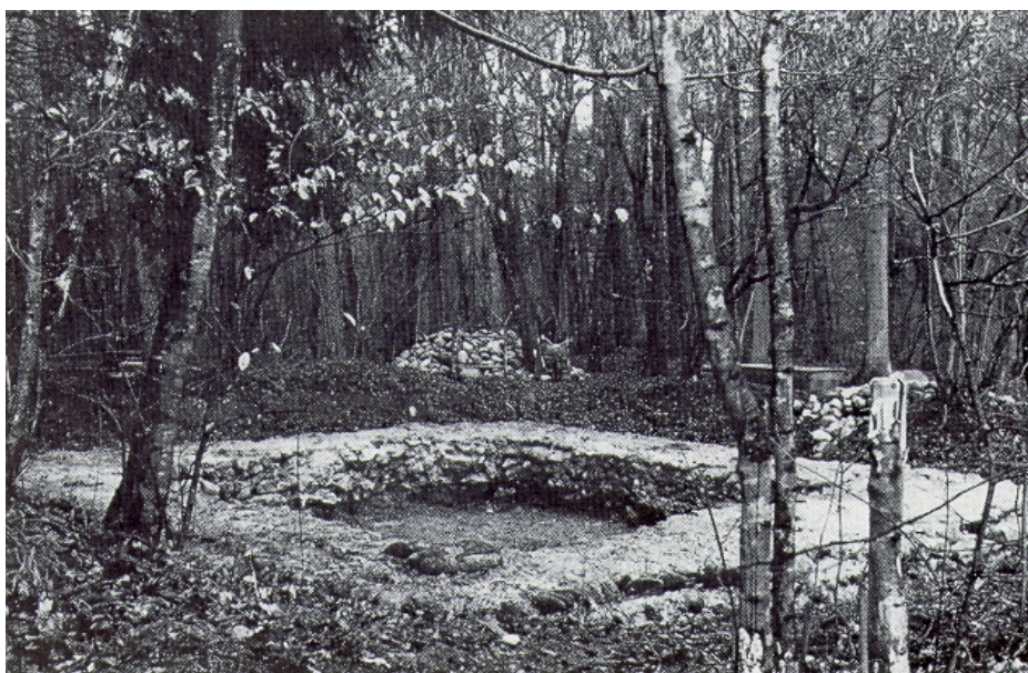
Abb. 6: Fundament der Römerwarte im Hard; während der Restaura- tionsarbeiten. Foto: Kantonales Hochbauamt, 1969.
