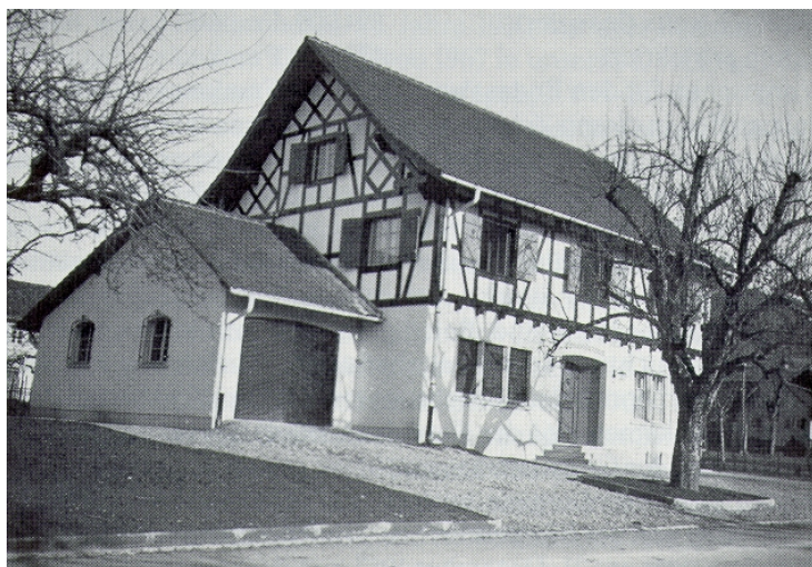
Abb. 28: Neues Gemeindehaus (Baujahr 1947) mit Feuerwehrlokal vor dem Umbau von 1991
