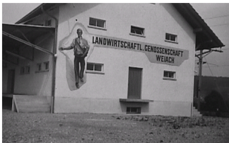
Abb. 32: Ehem. Lagerhaus der Landwirtschaftlichen Genossenschaft an der Kaiserstuhlerstrasse 44, erstellt 1957, heute LANDI Weiach, mit nordwestlichem Erweiterungsanbau von 2015.
